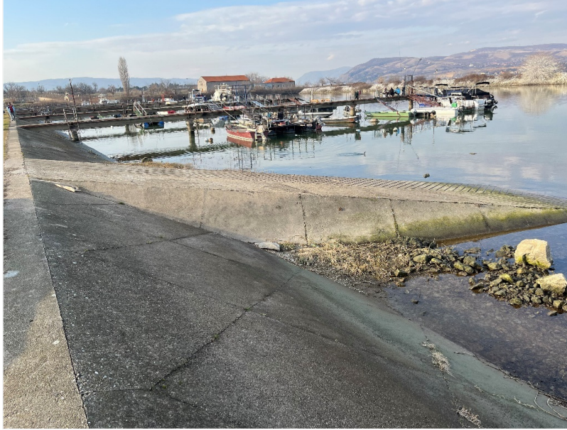
Сл. – Постојећа рампа за спуштање и извлачење пловила
