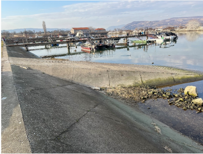
Сл. – Постојећа рампа за спуштање и извлачење пловила
